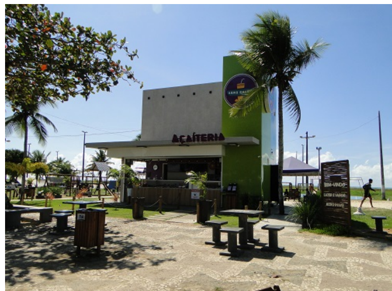
Foto 1 - Imóvel construído e utilizado pela Aeroshake
