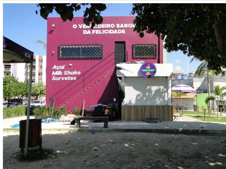
Foto 3 - Imóvel construído e utilizado pela Aeroshake
